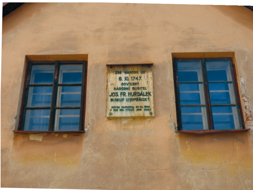
10. P. Josef František Hurdálek, pamětní deska, rodný domek, Náchod, čp. 148 (před demolicí). Foto: Mgr. Jan Čížek, 20. 4. 2021.
